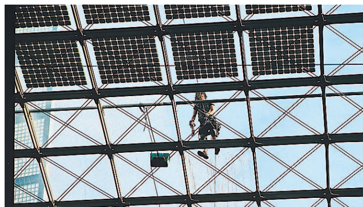
Auf dem Dach des Hauptbahnhof wird Solarstrom erzeugt. Foto: DB AG
