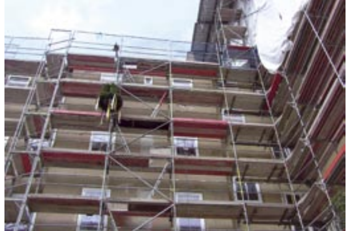
Richtkranz am Gerüst in der Karl-Kunger-Str.
